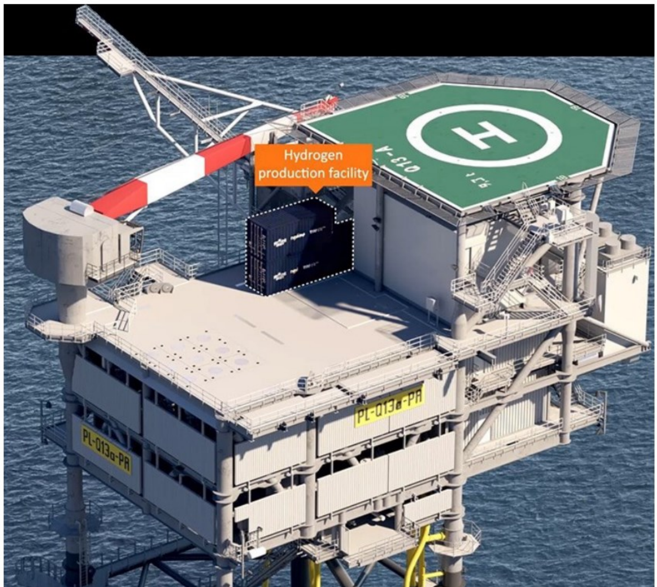
PosHYdon installatie: groene waterstof uit zeewater.
